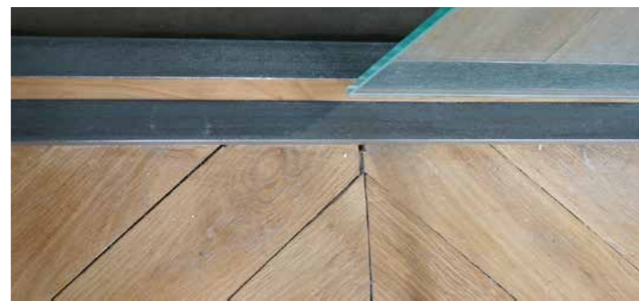
Double Portes coulissantes en verre et en merisier. Marche, poignée et incrustation en acier.
